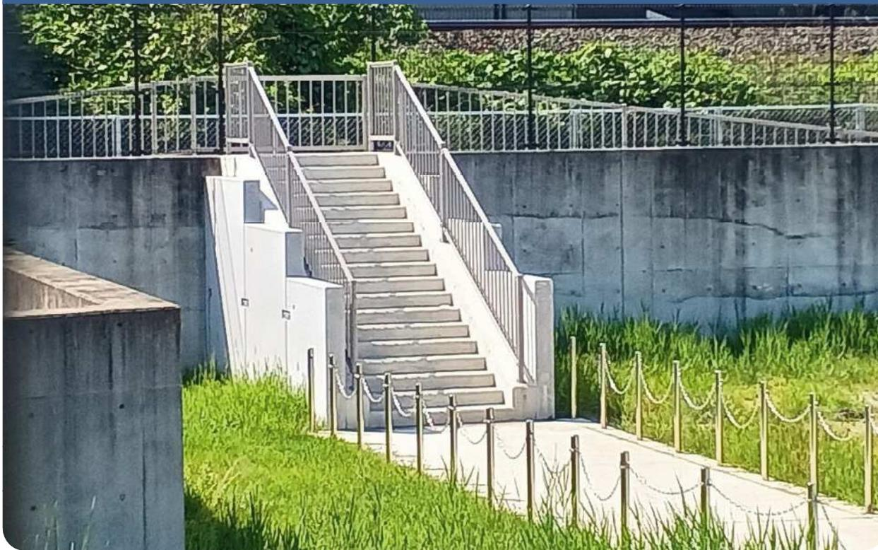
福岡県福津市の福間中学校第二グラウンド整備工事では、通常ストックヤードで資材保管に使用される擁壁を全く新しい方法で提案を行いました。生徒たちが歩道からグラウンドにアクセスするための階段の側壁として使用しました。
