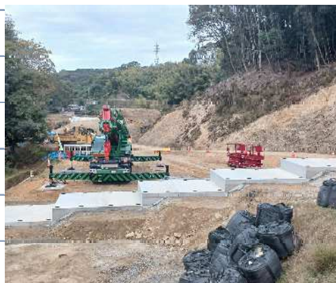
■基礎コンクリート施工状況
