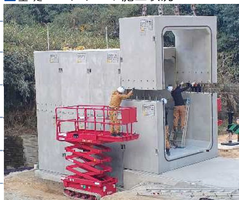
■製品据付状況
