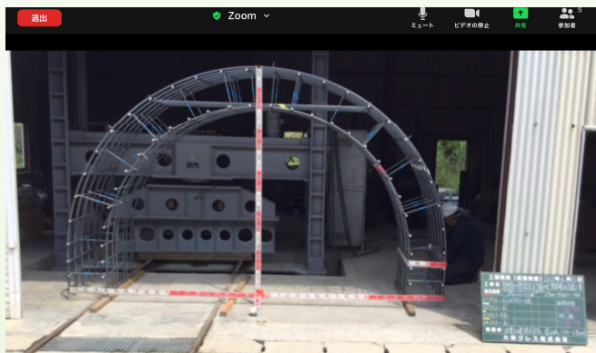
配筋検査の全体画面
