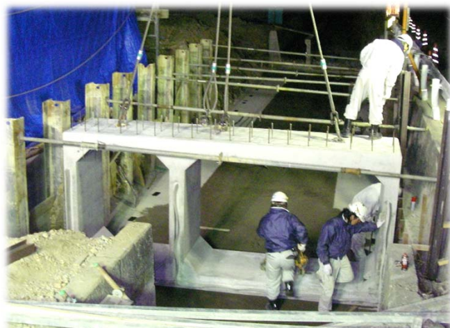
ボックスカルバート(2連式 止水板付き) 規格：W2250-1300×H1700 施工延長：19m×2箇所 事業主体：高知河川国道事務所
