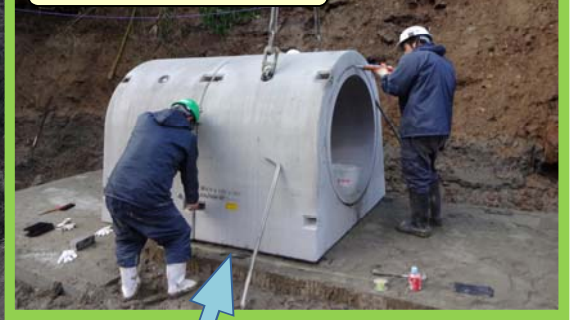
据付状況 製品設置→接合の繰返し
