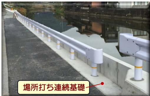
河川増水時の越流を防止したいが民地の高さなどの理由で、堤体をかさ上げできない場所に、**防護柵と越流防止胸壁(パラペット)**の目的を兼ねて築造することができます。主な特徴は、**壁体高さを5cm単位で製造できるため、経済的な断面を選択**できます。将来の盛土を見越してあらかじめL型擁壁としての照査をしておくことができます。製品同士はボルト連結のため、据え付けに特殊な作業がありません。製品背面から据え付け作業ができ、**安全に早く施工**できます。河川への排水管にはフラップゲートを取り付けることにより、逆流を防止できます。
