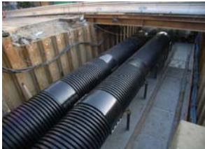
水換え・仮設工
