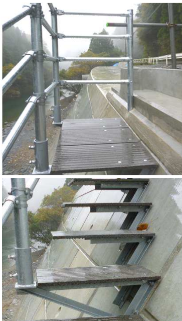
おどい場付近とフェンス基礎
