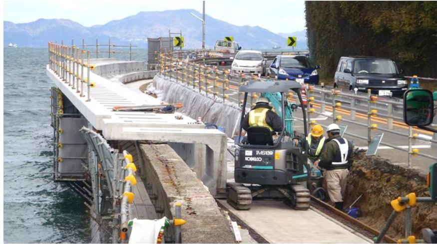
ただ、海岸沿いの環境に従来仕様では不適なため、**耐塩害性・暴風対策の特別仕様**を規格しました。まず鉄筋配りを厚くして耐塩害性を向上させるとともに、下面からの巻上風荷重を考慮して、風そのものを透過する歩道面開口(緩衝工)を設けました。開口部を埋めるグレーチングは塩害に強く軽量のFRP製を採用し、お遍路さんの杖が入らないよう、パーピッチにも注意しています。基礎配筋は樹脂塗装鉄筋を使用し、アンカーボルト等はSUS製を選択しました。
