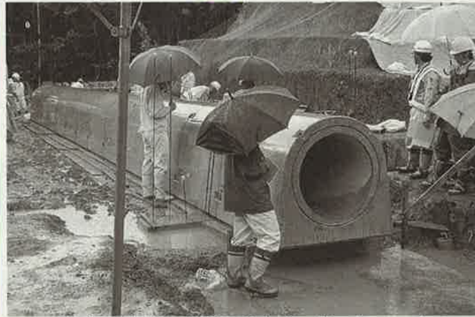
県内で初めて採用されたプレキャスト底樋管
