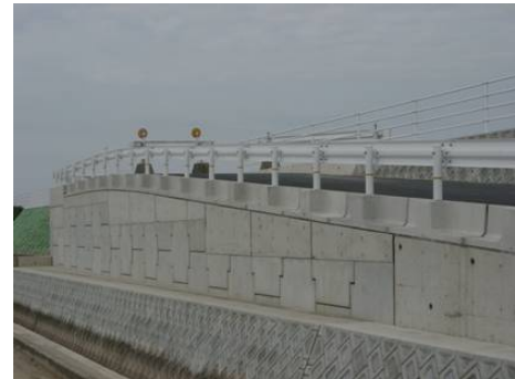
写真-5 補強土壁への設置
