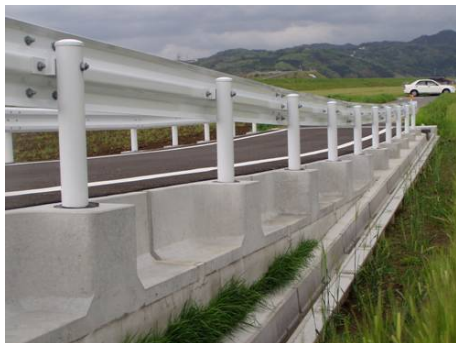
写真-4 L型擁壁への設置
