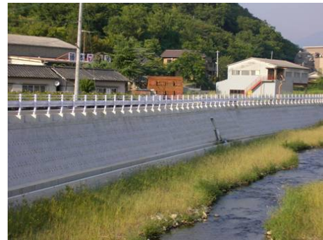
写真-3 間知ブロックへの設置
