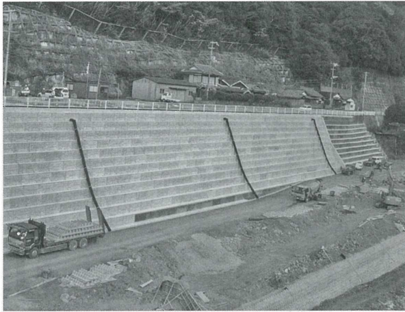
箱型擁壁の再利用による復旧現場
