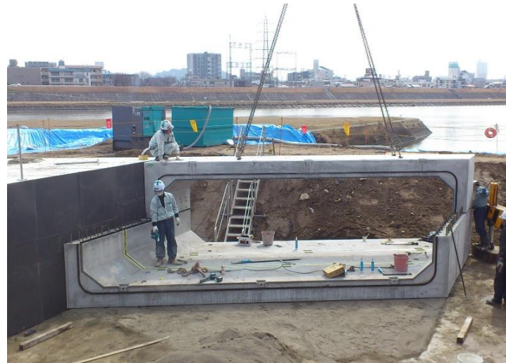
上部材の据付状況
