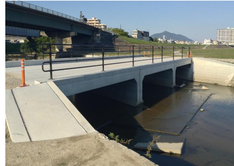
河川敷の緊急道路として、3連のボックスカルバート
