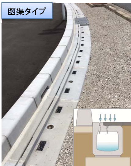
店舗乗り入れ部 (グレーチング仕上げ)
