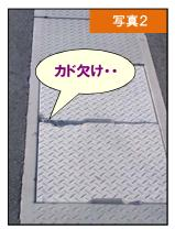
また店舗駐車場などにFV側溝 標準型を使用された場合、天端の開口部に コンクリート蓋が使われ、写真2のように蓋のカドが欠ける場合もあります。
