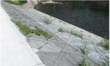
今回の現場は、ブロックマット工法 で検討をしていたのですが、可動堰を 設置することもあり、より強固なコンク リートブロック構造にしたいとの要望 でポラポットの採用となりました。
