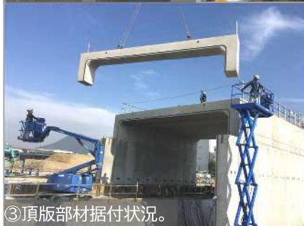
② 側壁部材据付状況。
