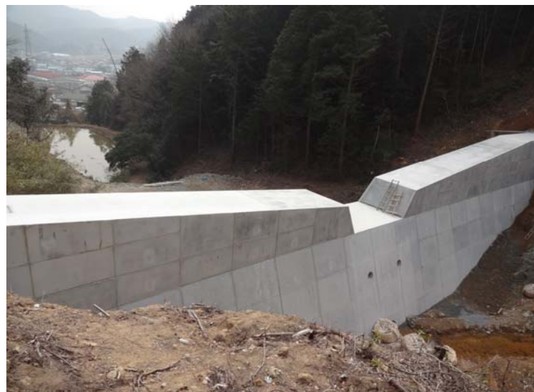
砂防堰堤完成
