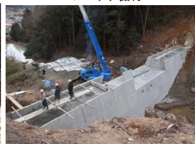
コンクリート打設
