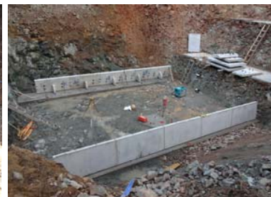
ブロック据付
