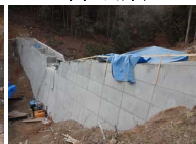
所定の高さまでコンクリート打ち
